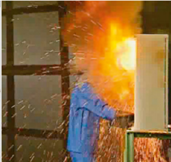
Lichtbogen beim Ziehen von NH-Sicherungen
