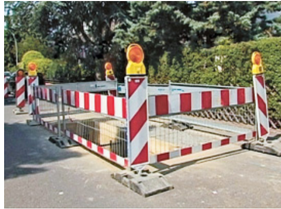
Absicherung einer Grube
