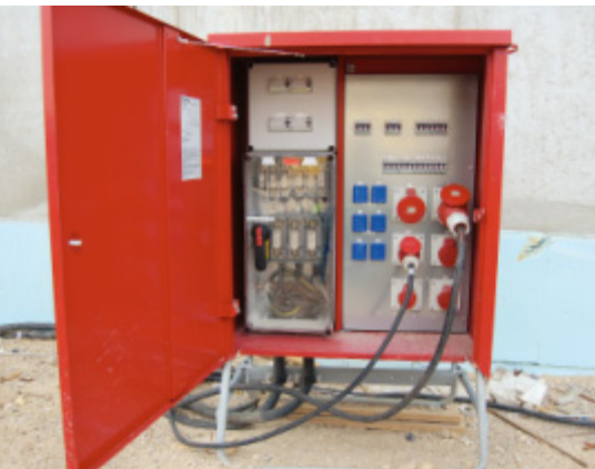
Baustromverteilerschrank
